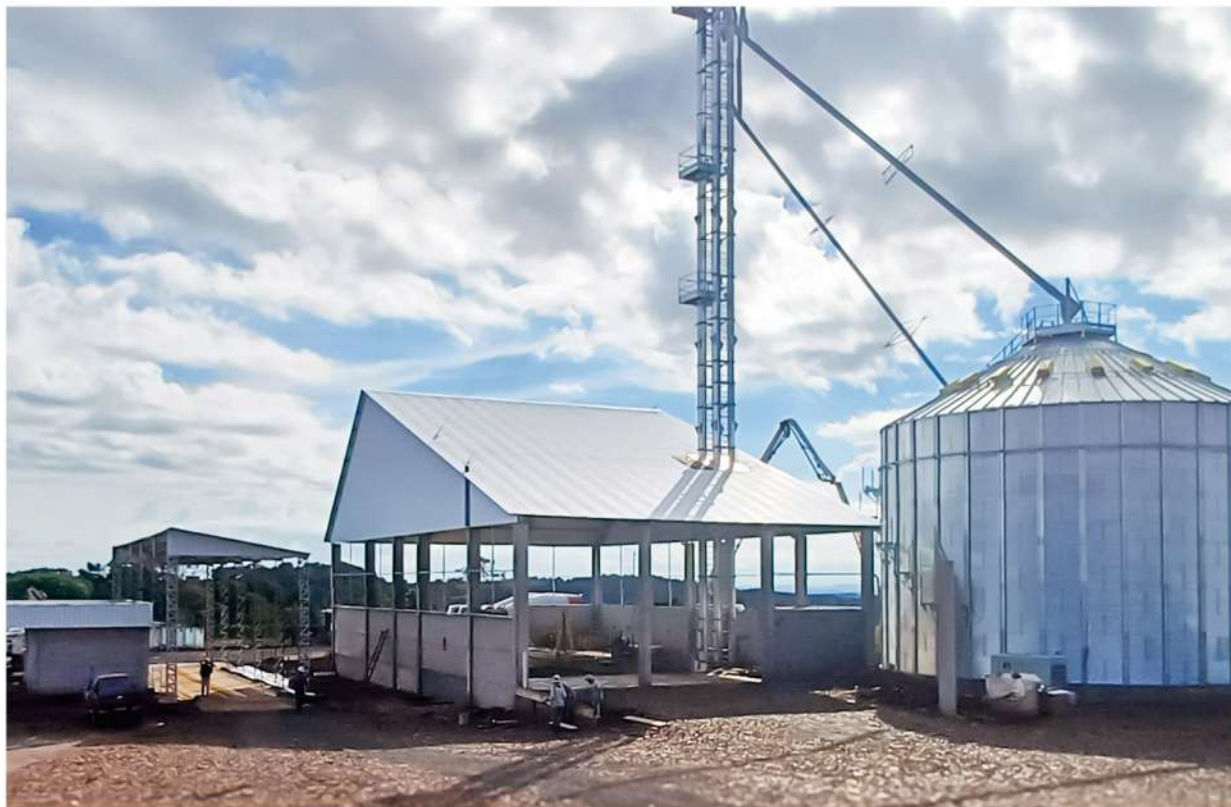
Construído em 2024 a UNIDADE DE RECEBIMENTO E ARMAZENAMENTO VILA PARAÍSO
